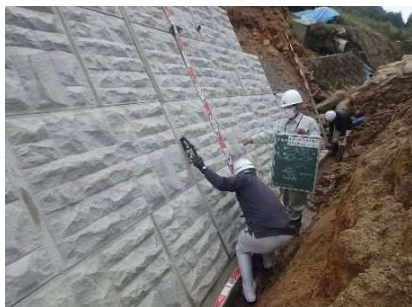
玉湯川 河川災害復旧工事 (松江県土)
