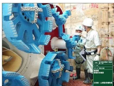
浦ヶ部国道9号横断工事「ボックス推進」（安来市下水道課）
