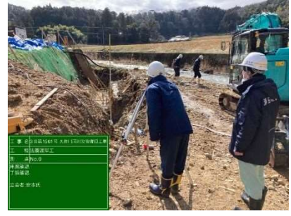
久佐川 河川災害復旧工事 (浜田県土)
