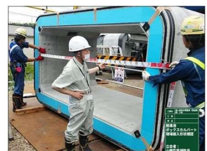
浦ヶ部国道9号横断工事「ボックス推進」（安来市下水道課）
