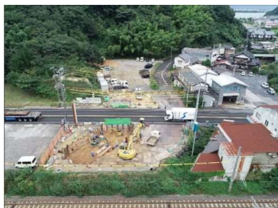
浦ヶ部国道9号横断工事「ボックス推進」（安来市下水道課）
