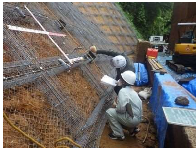
枕木山線 道路災害復旧工事 (松江県土)
